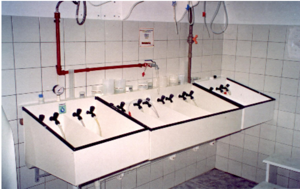
Figura 5 - Bancada de reprocessamentos de linhas e deslizadores
